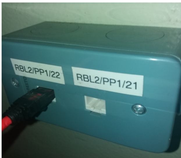
Figura 5.5: Exemplo de identificação de ponto de rede em condute com dois pontos (X2). Ref. UFFS.
